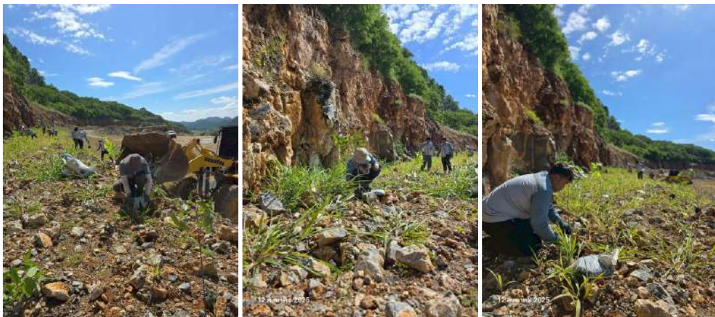
รูปที่ 13 พื้นที่ปลูกต้นไม้ จุดที่ 1 บริเวณชั้น 2 Zone B1 ดำเนินการเตรียมพื้นที่ โดยใช้แบ็คโฮ ทำคันดิน วัดระยะตำแหน่งในการปลูกต้นไม้ ใช้ระยะ 2x4 เมตร และเตรียมต้นไม้ที่ปลูก
